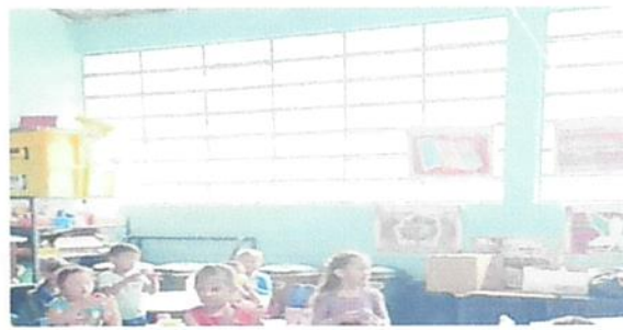
Foto 2: Sustitución de ventanas tipo perciana por ventanas PVC
