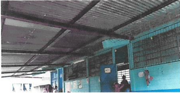
Foto1: Sustitución de lamina de area de actividades por lamina troquelada
