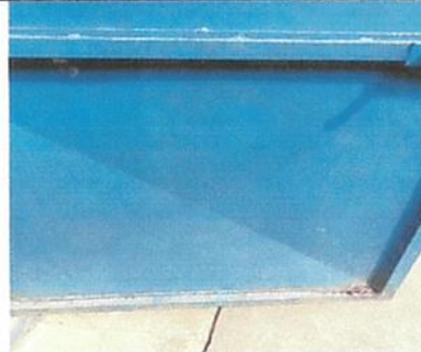
Foto 4: Mantenimiento de puertas de metal de aulas, lijado, cepillado y pintura de puerta.
